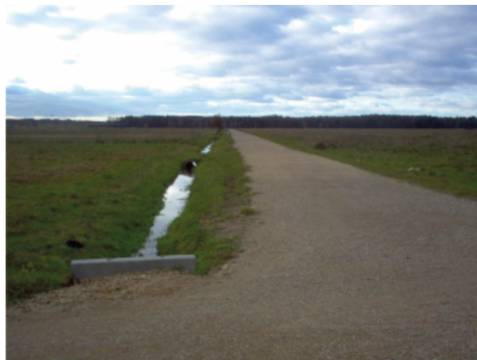
Droga na obiekcie Lgota Mała – Teklinów gmina Kruszyna po scaleniu
