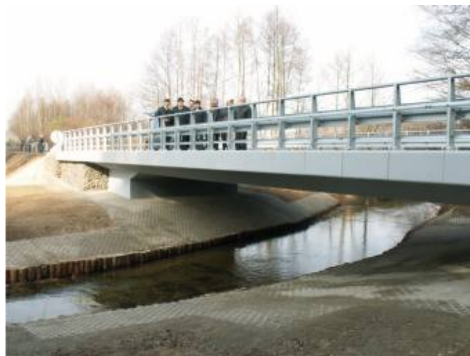
Starosta A. Kwapisz wraz z pracownikami PZD podczas odbioru końcowego mostu
