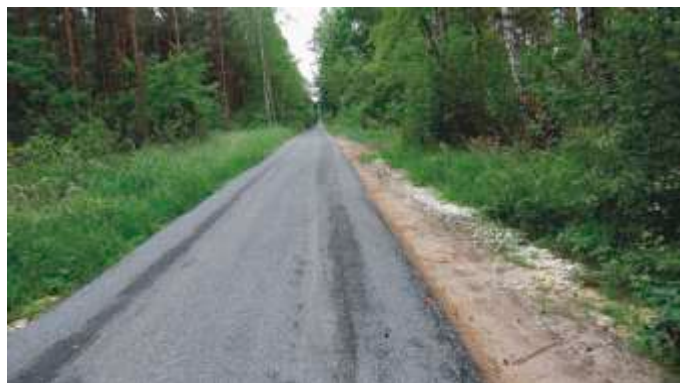
Droga 2 w Białej Wielkiej po scaleniu
