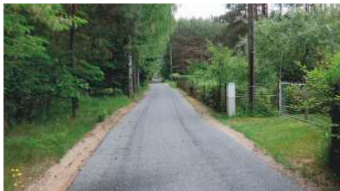
Droga w Białej Wielkiej po scaleniu
