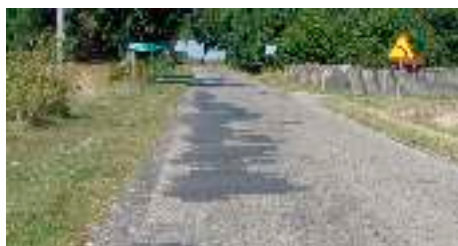
Droga powiatowa 1084 S przed przebudową
