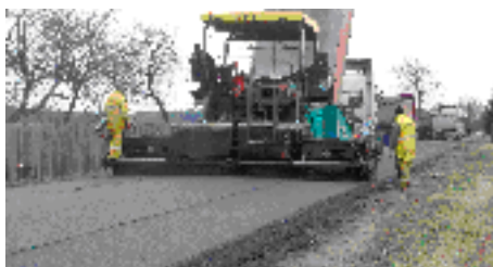
W trakcie przebudowy
