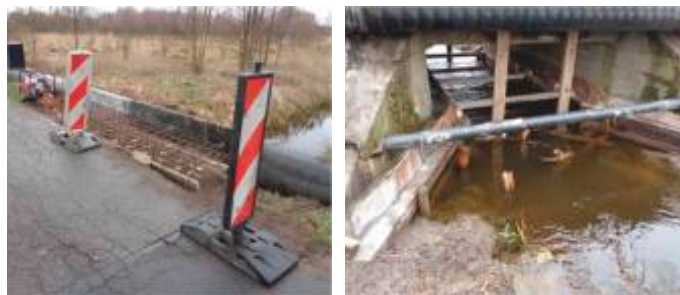
Most na Stradomce w trakcie przebudowy
