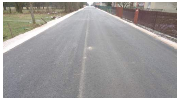
Przebudowana droga w Oblasach
