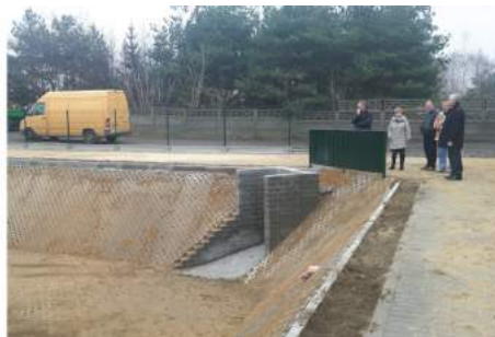
Odbiór zbiornika odparowującego Wierchowisko 2016
