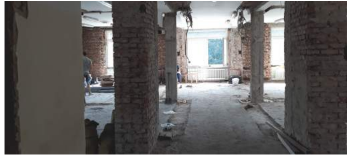
Odnotaliśmy także postęp prac remontowych bloku operacyjnego
