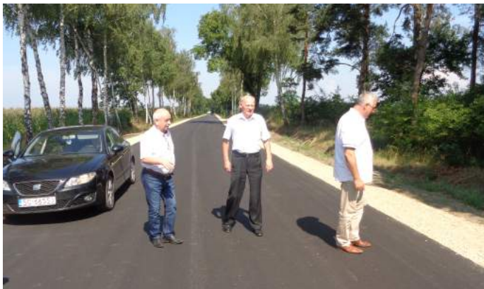
DP 1025 S Widzów - DK 91 1 - przebudowa zakończona
