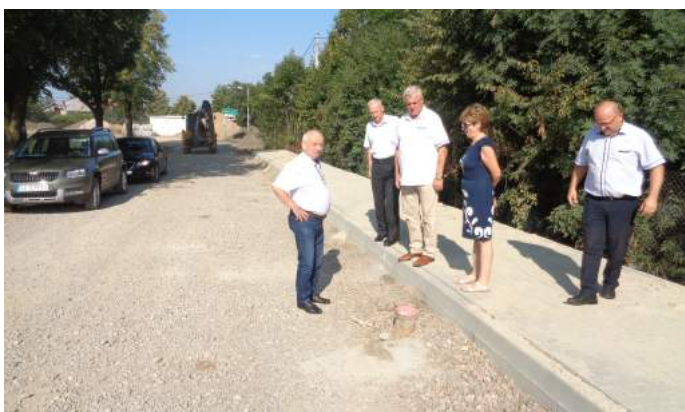
DP 1060 S m. Marianka Rędzińska - przebudowa w trakcie realizacji
