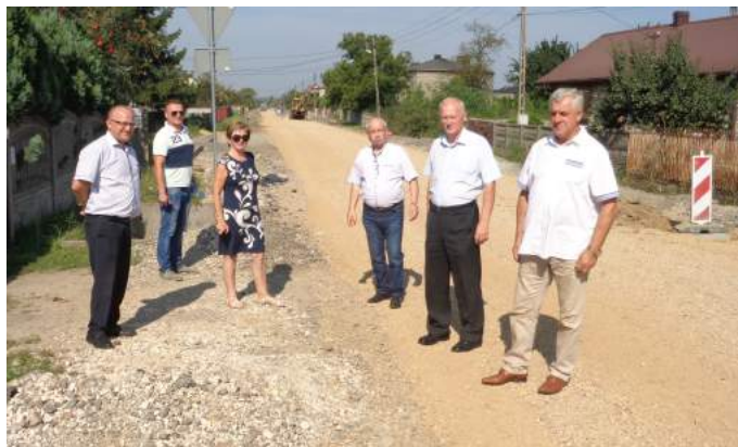
DP 1025 S Kokawa - Rybna - przebudowa w trakcie realizacji
