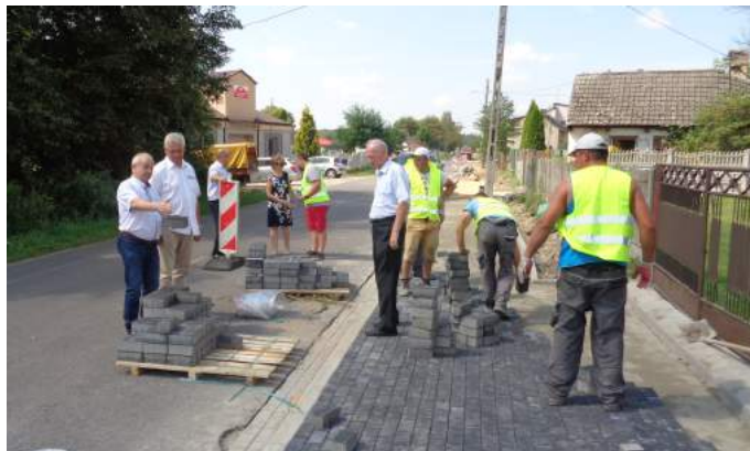
DP 1040 S m. Kobyłczyce - Budowa chodnika 1
