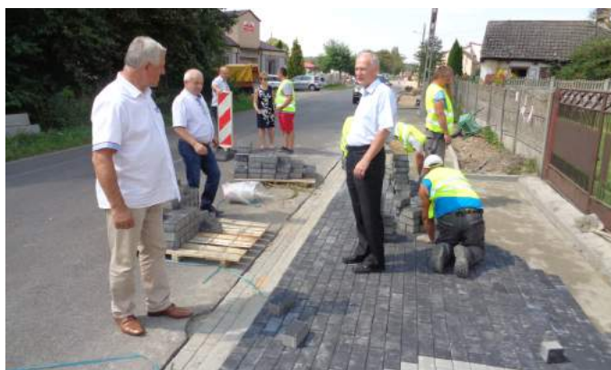
DP 1060 S w m. Wancerzów - Budowa chodnika w trakcie realizacji
