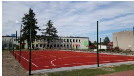
Budowa boiska wielofunkcyjnego
